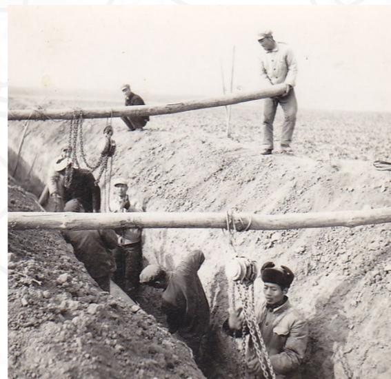
△ 建厂初期基建现场
